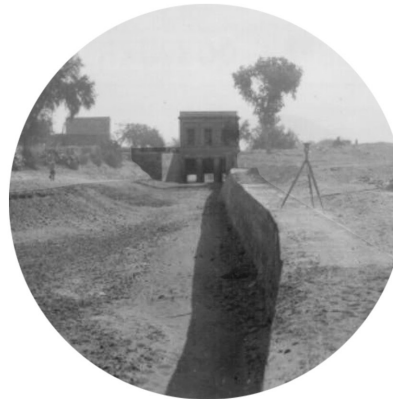
3 - Canal de Sacramento excavation
