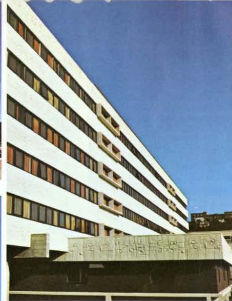
6 Foyer Patro, Rivière du Loup, Que.
