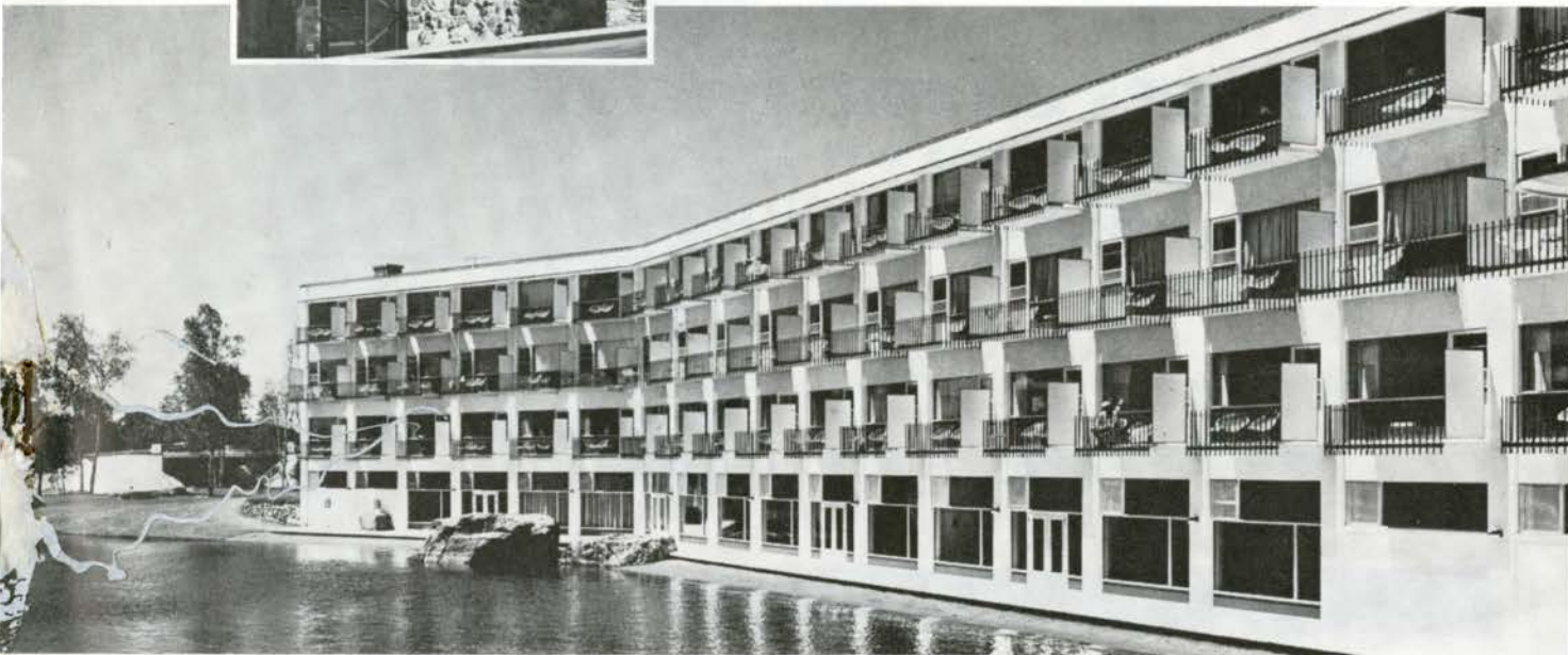
HOTEL L'ESTEREL, Ville d'Estérel, P.Q.; Architect: Jean-Guy Clement; Contractor: Simard et Freres Cie. Ltée. Rotary Oildraulic Elevator sold and installed by Alpin Elevator Co., Ltd., Montreal, P.Q.
