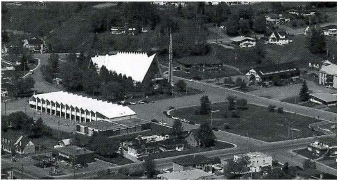
Fig. 6. Vue aérienne de l'église. (Photo Pierre Lahoud)
