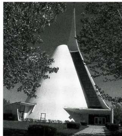
Fig. 23. Église Notre-Dame-de-Fatima, Jonquière, Desgagné et Côté, architectes, 1963. (Photo Josée Vaillancourt)
