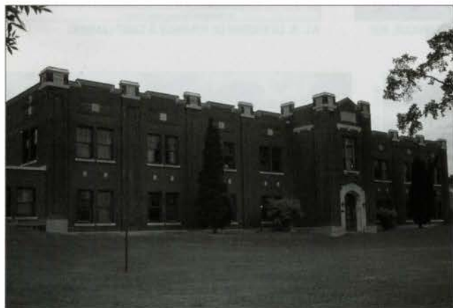
ILL. 11. L'USINE DE POMPAGE À SHAWINIGAN. | CLAUDINE DÉOM, 2001.
