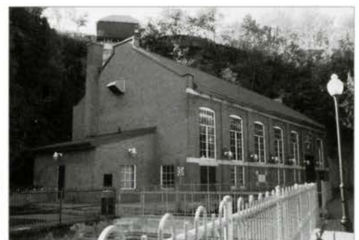
ILL. 10. L'USINE ÉLECTRIQUE À RIVIÈRE-DU-LOUP. | CLAUDINE DÉOM, 2001.
