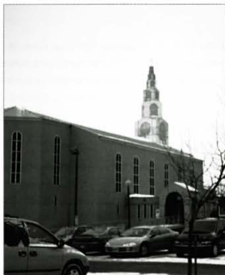
ILL. 17. L'ÉGLISE SAINT-FERDINAND, LAVAL. GILLES LAVIGUEUR, MARC DROUIN, ARCHITECTES, 1989. LE CHEVET.
