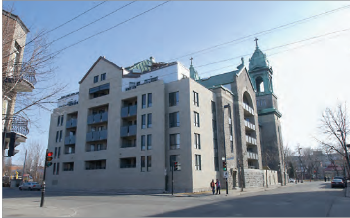
ILL. 35. ANCIENNE ÉGLISE SAINT-JEAN-DE-LA-CROIX AU CŒUR DE LA « PETITE ITALIE, DANS LE QUARTIER ROSEMONT. CONSTRUITE EN 1926 D'APRÈS LES PLANS DE ZOTIQUE TRUDEL. TRANSFORMÉE EN 58 UNITÉS D'HABITATION DEPUIS 2004. BEÏQUE, LEGAULT ET THUOT, ARCHITECTES. | LUC NOPPEN, 2005.
