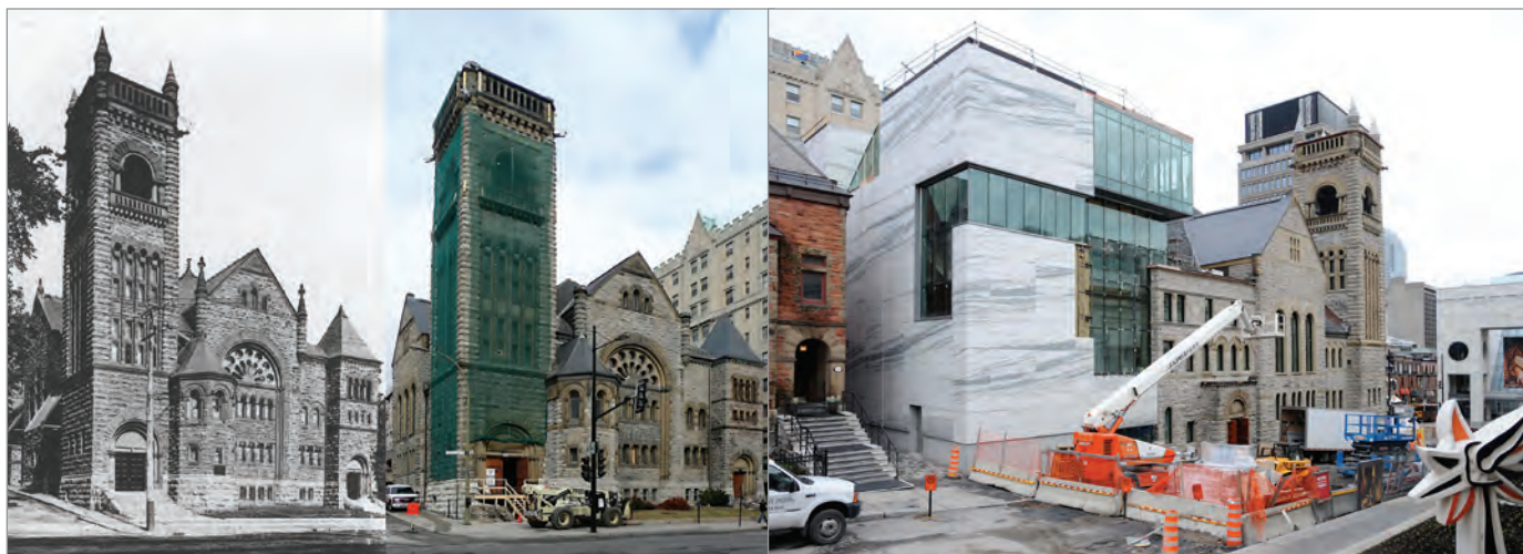
ILL. 41-42. ANCIENNE ÉGLISE ERSKINE AND AMERICAN / MUSÉE DES BEAUX-ARTS DE MONTRÉAL. ELLE DEVIENDRA BIENTÔT LE PAVILLON DES ARTS CANADIENS ET UNE SALLE DE CONCERT SERA AMÉNAGÉE DANS LA NEF. CETTE ÉGLISE DU CENTRE-VILLE A ÉTÉ CONSTRUITE ENTRE LES ANNÉES 1893 ET 1894 D'APRÈS LES PLANS DE L'ARCHITECTE ALEXANDER COWPER HUTCHISON. | GUILLAUME ST-JEAN, 2009 ET 2010.
