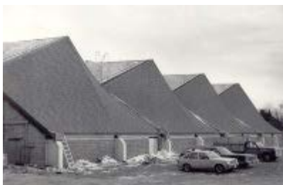
Dal Rink - Exterior - Roof, March 1982
