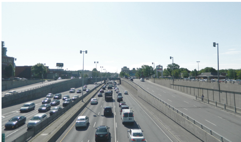
Décarie Expressway, Montréal, Québec. 2012.
