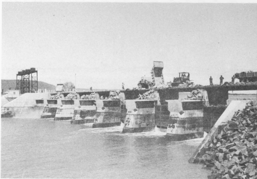
Figure 2.—Barrage de la rivière Annapolis. Les hausses ont été mises en place et régularisent le débit de la rivière. Une fois terminé, le remblai de pierres aura 60 pieds de largeur au sommet.
