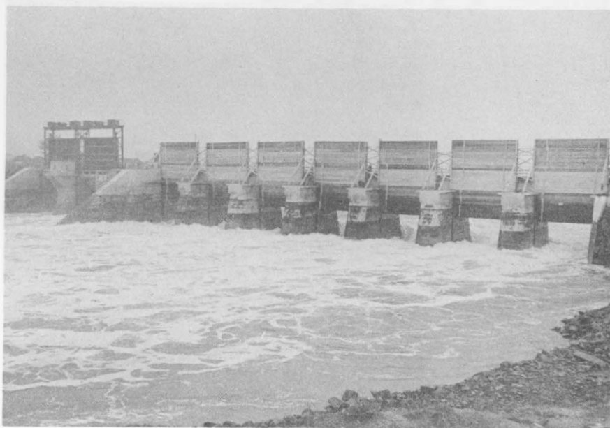
Figure 1.—Barrage de la rivière Annapolis, comté d'Annapolis (N.-É.). Hausses prêtes à être mises en place. La chaussée a détourné entièrement le cours de la rivière vers cet endroit. Les constructions permanentes de régularisation apparaissent à gauche dans la photographie.
