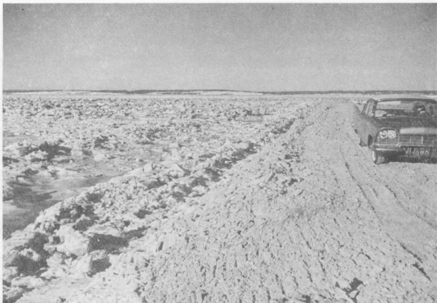
Figure 6.—Marais d'Aulac, comté de Westmorland (N.-B.). Le revêtement léger de pierre mis en place durant l'hiver sur la digue protège celle-ci contre l'érosion par les vagues.
