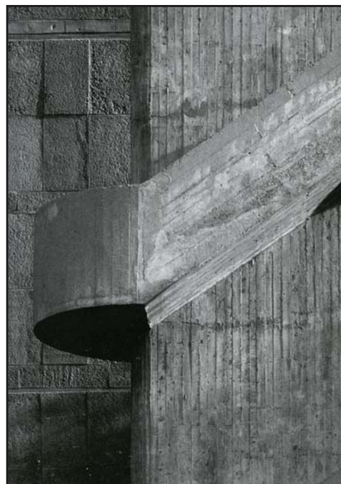
Fig. 5. Unité d'habitation's béton brut; from Jenkins, Unité d'Habitation: Marseilles .
