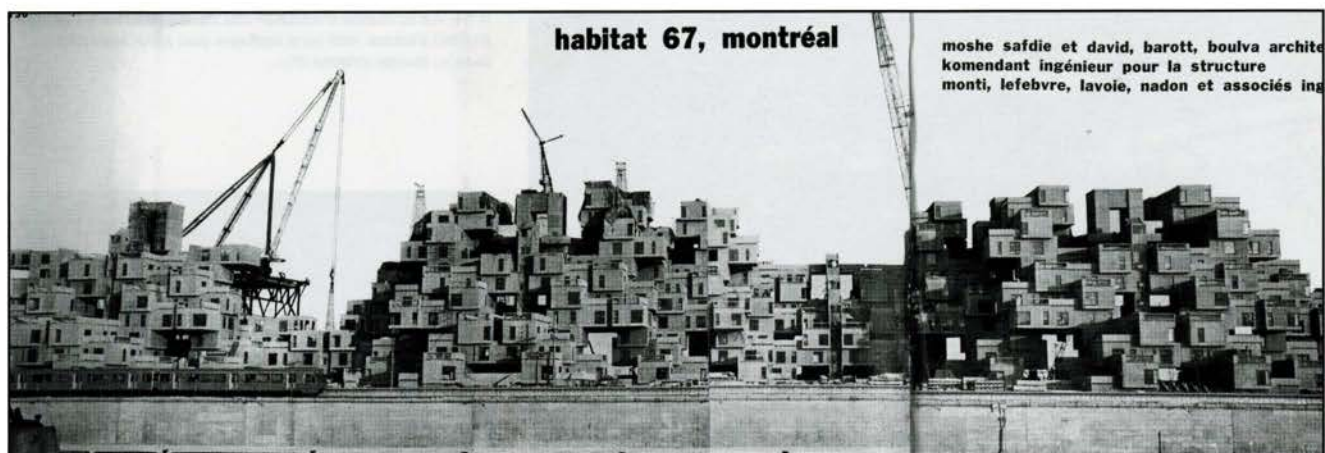
Ill. 12. Photographie du chantier d'Habitat 67 parue dans L'Architecture d'aujourd'hui de février-mars 1967 (variantes dans toutes les publications du chantier recensées sauf dans celle de Design de janvier 1967).
