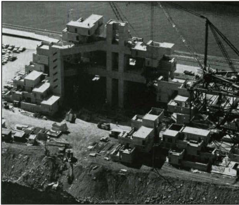
Ill. 14. Vue du chantier d'Habitat 67 côté fleuve publiée dans Canadian Architect d'octobre 1966 (sans équivalent dans aucun autre article dédié au chantier d'Habitat 67).
