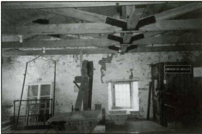
Fig. 15. Le moulin Légaré, Saint-Eustache, Qc. Pignon sud à l'étage avec la trémie de la meule en opération. (Jean Bélisle, Maître d'œuvre de l'histoire, 5-0, 1999)
