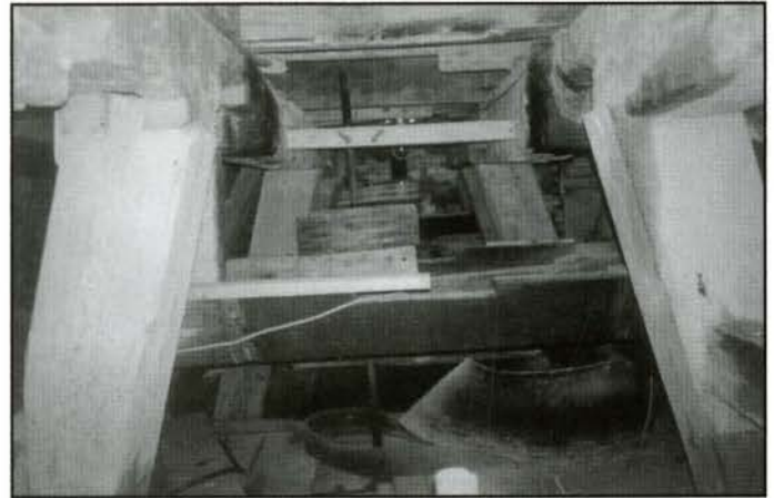
Fig. 12. Le moulin Légaré, Saint-Eustache, Qc. Bâti trapézoïdal supportant les meules. (Jean Bélisle, Maître d'œuvre de l'histoire, 5-17, 1999)
