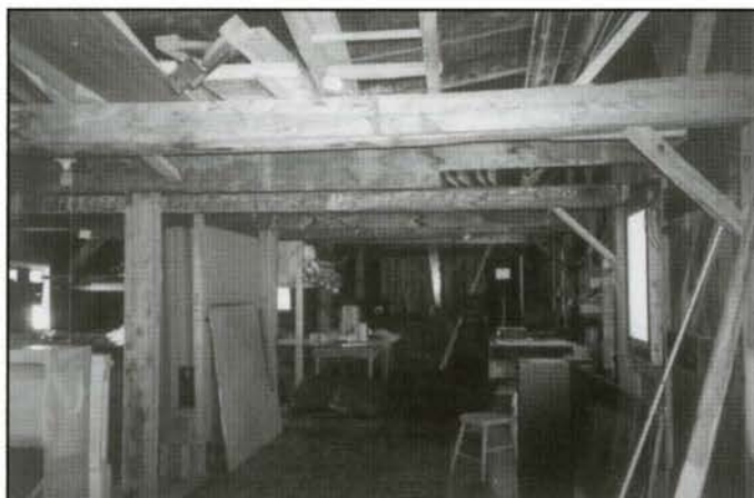
Fig. 21. Le moulin Légaré, Saint-Eustache, Qc; L'étage du moulin à scie vers l'ouest
