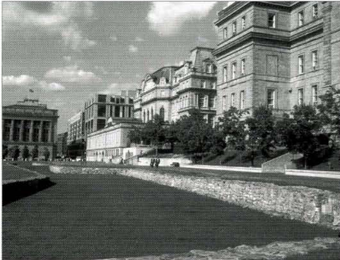
ILL. 7. VESTIGES DU MUR D'ENCEINTE DE MONTRÉAL QUE FAIT CONSTRUIRE CHAUSSEGROS DE LÉRY ENTRE 1717 ET 1744.
