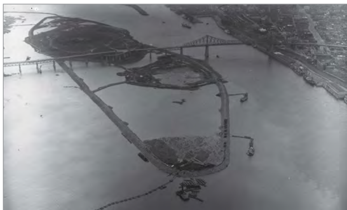
ILL. 4. VUE AÉRIENNE DU DÉBUT DES TRAVAUX DE REMBLAIEMENT EN VUE DE L'EXTENSION DES ÎLES SAINTE-HÉLÈNE ET NOTRE-DAME, 1964. | ARCHIVES DE LA VILLE DE MONTRÉAL, VM94_EX18-002.
