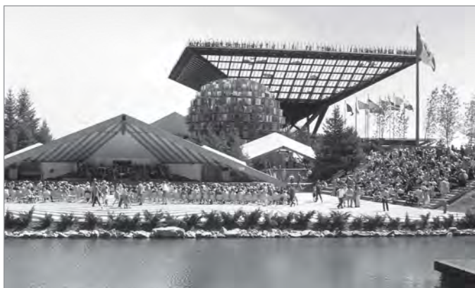
ILL. 8. L'ENSEMBLE DU PAVILLON DU CANADA ET LA STRUCTURE PYRAMIDALE INVERSÉE DU PAVILLON KATIMAVIK, EXPO 67. ROD ROBBIE ET COLIN VAUGHAN (ASHWORTH, ROBBIE, VAUGHAN AND WILLIAMS ARCHITECTS AND PLANNERS) ET ARTHUR ERICKSON, ARCHITECTE. | ARCHIVES DE LA VILLE DE MONTRÉAL, P123-D2-P043.
