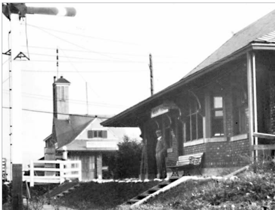
ILL. 10. GARE ET CASERNE DE POMPIERS EN 1928. | ARCHIVES DE LA CNR.
