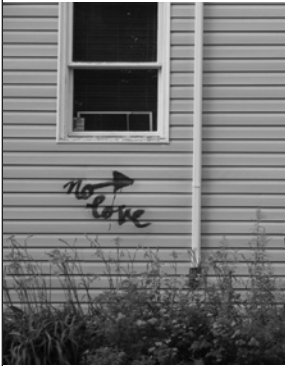
graffitti, window, pipe
